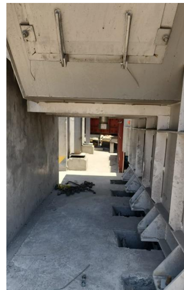
Fig. 09 – Alinhamento correto do ventilador com “cavas” para espera do chumbador.
