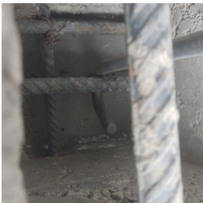
Fig. 10 – Chumbador ancorado à ferragem do concreto
