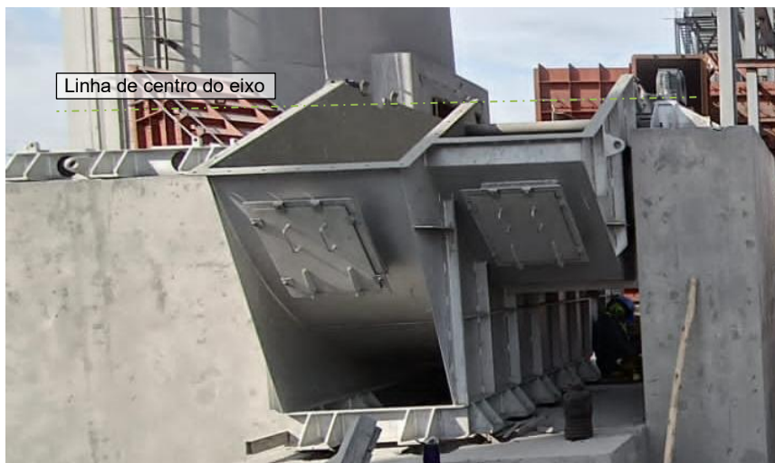
Fig. 11 – Verificar alinhamento entre as bases de mancal e motor.
