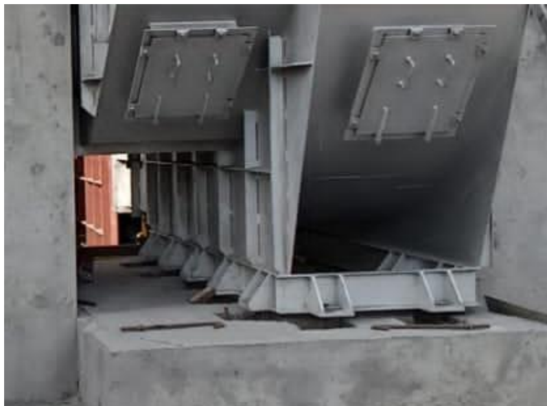
Fig. 09 – Alinhamento correto do ventilador com “cavas” para espera do chumbador.
